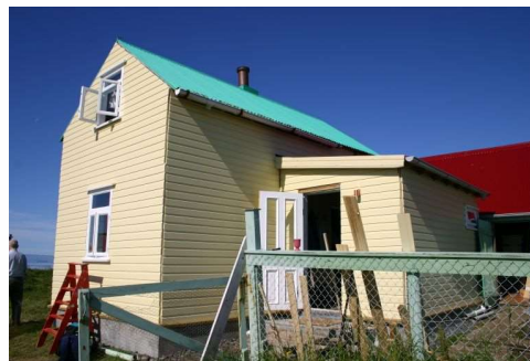
Alheimur 2006, verið að klæða húsið vatnsklæðningu
